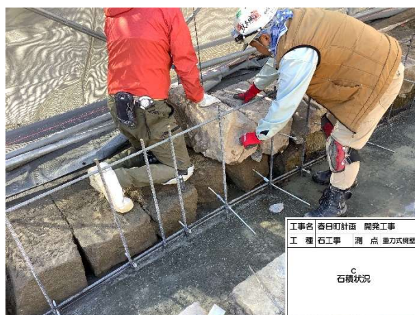
③ 従前の石材の組み直し作業
