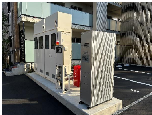
純水素燃料電池の設置状況
