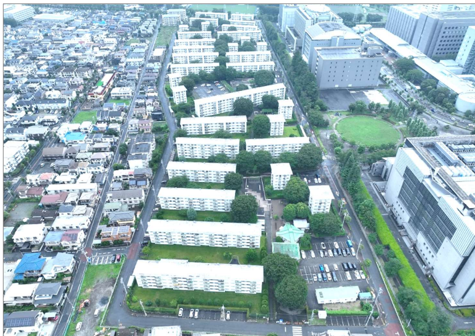
現在の府中日鋼団地全景
