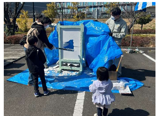
バルコニー隔壁破壊
