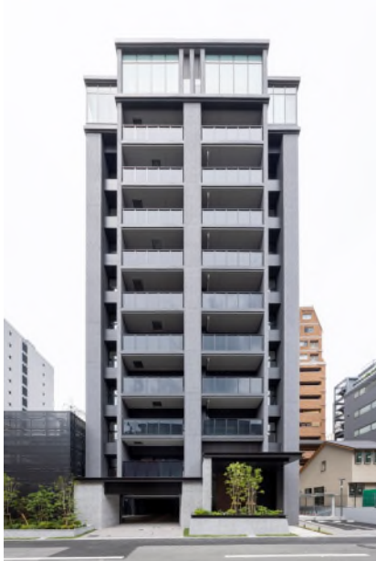
外観竣工写真
