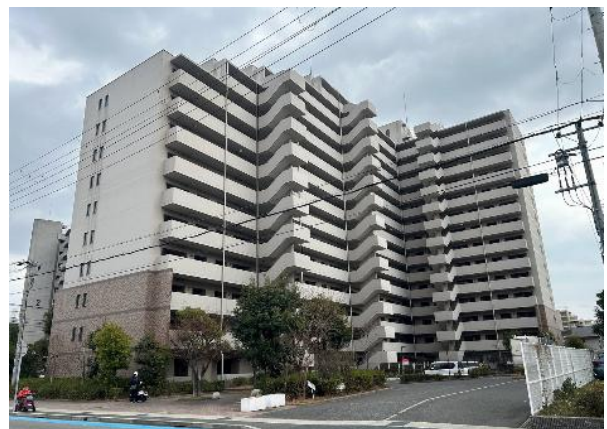
建物外観写真(現況)
