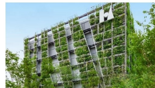
[多目的実験棟の緑化壁面]
