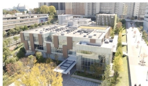
[長谷工テクニカルセンター全景]
