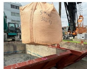
建設汚泥への竹チップ添加
