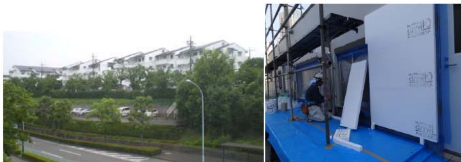
[エステート鶴牧 4・5 住宅(左)、外断熱改修の様子(右)]
