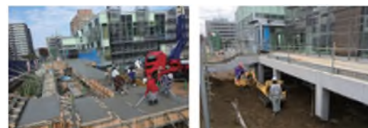
H-BAコンクリート施工風景
