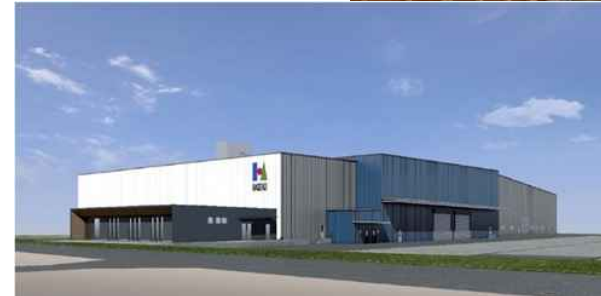
プレキャストコンクリートの更なる活用に向けた自社工場の設立
