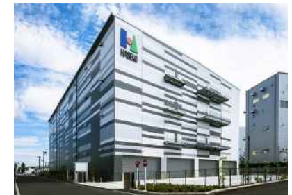
当社単独で開発・設計・ 施工した物流施設
