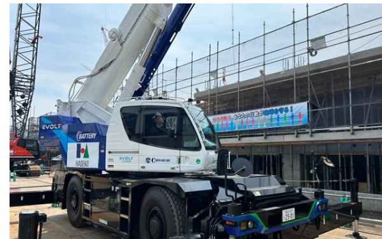
バッテリー式フル電動ラフテレーンクレーンの採用
