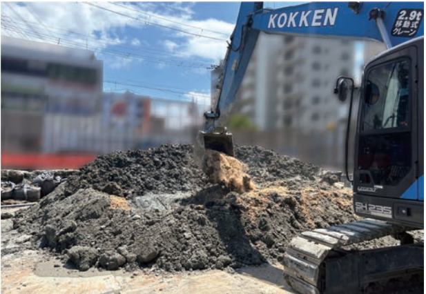
建設汚泥に竹チップを混合する様子
