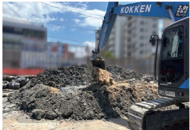
建設汚泥に竹チップを混合する様子
