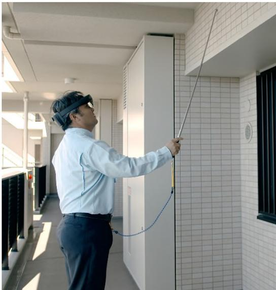
HoloLens 2 を付けた打診検査の様子
