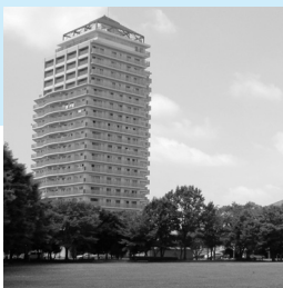
公園に隣接する集合住宅。住環境に恵まれている
