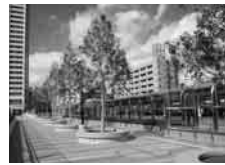
2棟の超高層棟を結ぶベデストリアンデッキ
