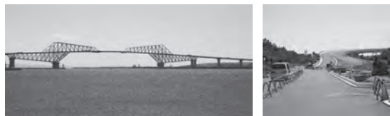
「東京ゲートブリッジ」全景 江東区若洲地域での東京港臨海道路
