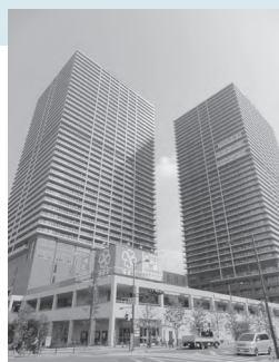
2013年2月に全体竣工となった「MEGA CITY TOWERS」
