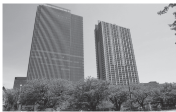
6月15日に竣工した「飯田橋グラン・ブルーム」と「パークコート千代田富士見ザタワー」
