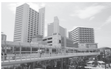
「海老名」駅東口側。再開発ビル、マンションが建設済み
