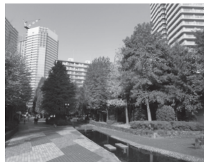
分譲マンション「パークシティ新川崎」
