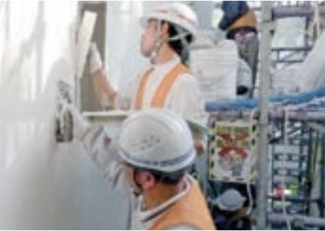
断熱材の上から鏝で仕上げる(左官仕上げ)
