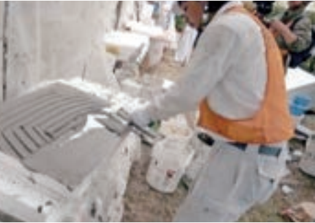
断熱材に樹脂モルタルを塗布
