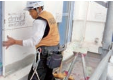
外壁に断熱材を貼り付け
