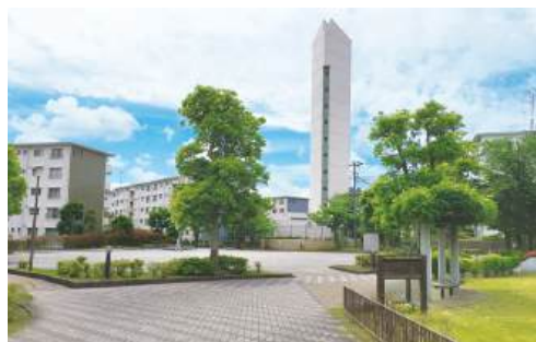
【洋光台南第一住宅の給水塔(解体前)】
