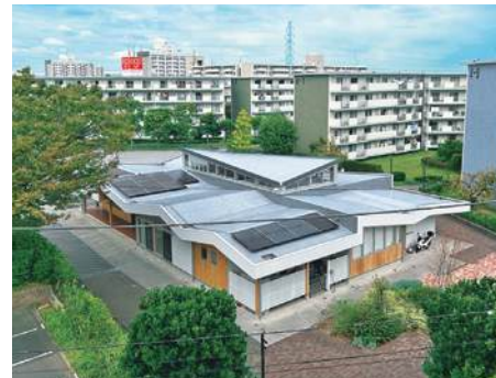
【連続折れ屋根と浮き屋根の外観】
