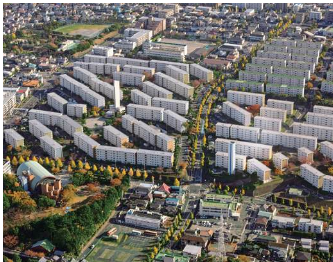
【給水塔解体前の洋光台団地】
