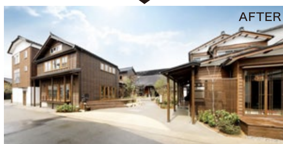
写真提供：空き家をリノベーションした輪島KABULETの拠点施設（輪島KABULET）
