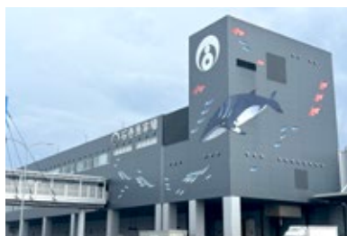
石巻魚市場：荷捌き所の延長は875.47mあり、ギネス世界記録にも認定されている。
