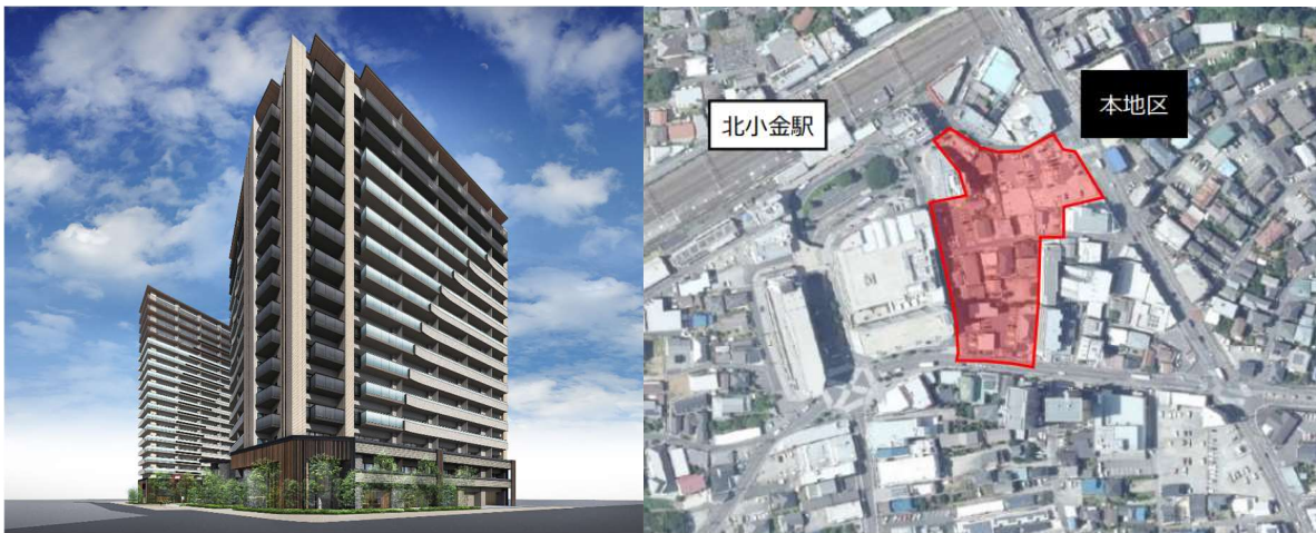
再開発建物完成イメージ（現在計画中であり、今後変更となる可能性がございます）
