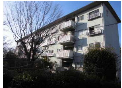
従前建物の外観写真
