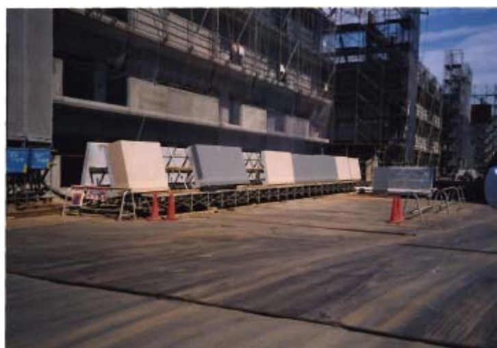
【製造中（仕上げ段階）のPC板】
