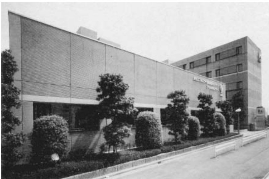
【『技術研修センター』外観】
