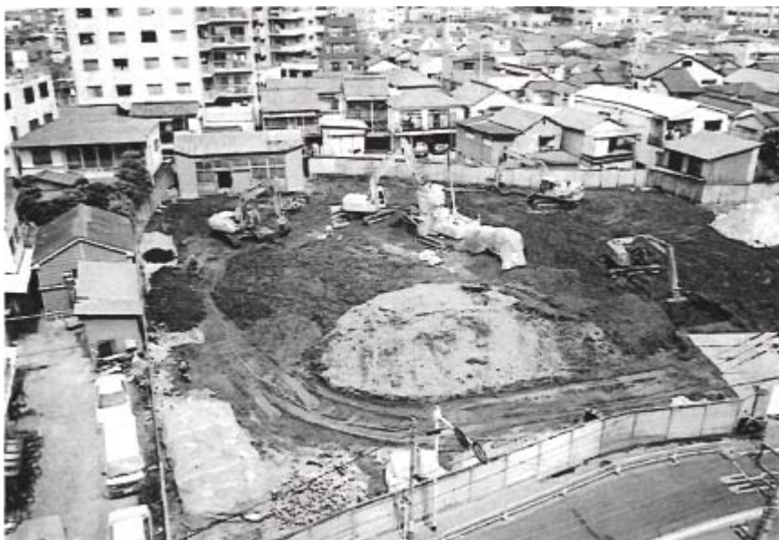
【土壌修復工事風景】
