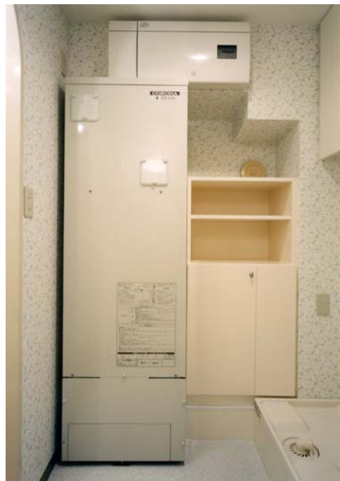
【「次世代オール電化リフォーム」の一例：電気温水器→エコキュート】
