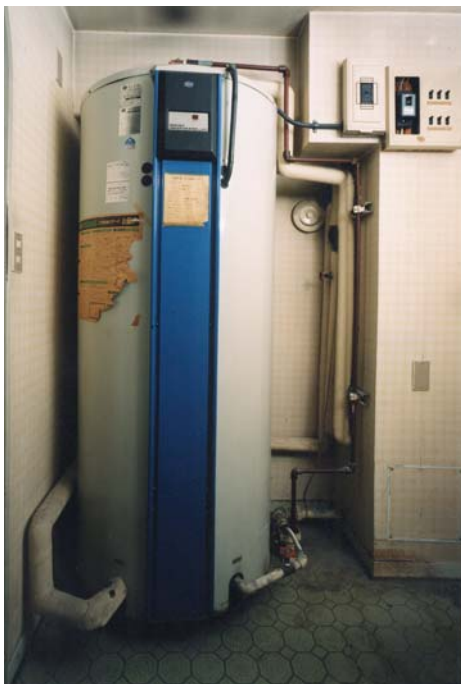
【「次世代オール電化リフォーム」の一例：電気温水器→エコキュート】
