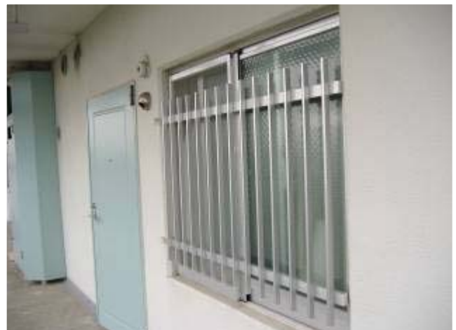
[リサッシ施工後]
