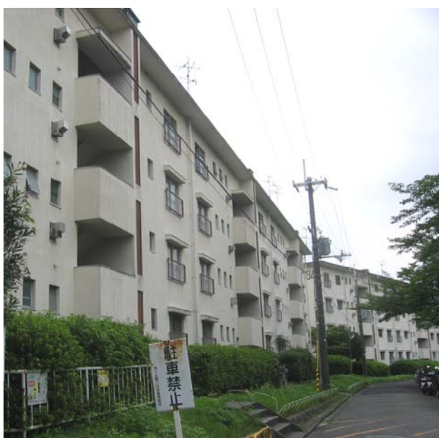
[従前建物 豊中・旭ヶ丘第二住宅]
