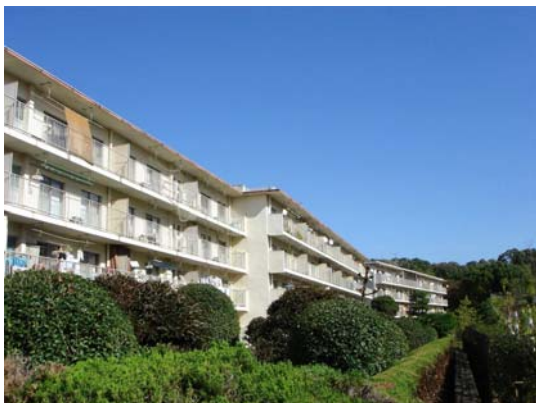
【「東丘住宅」現況建物（敷地南側から）】
