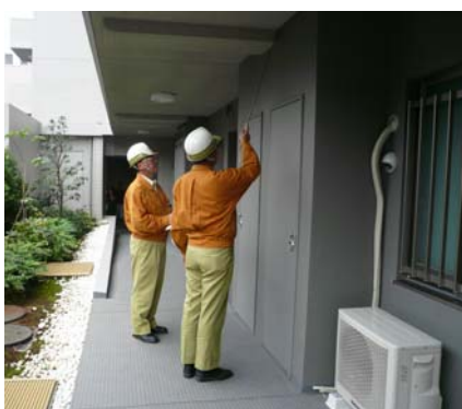
[定期点検サービスの様子]
