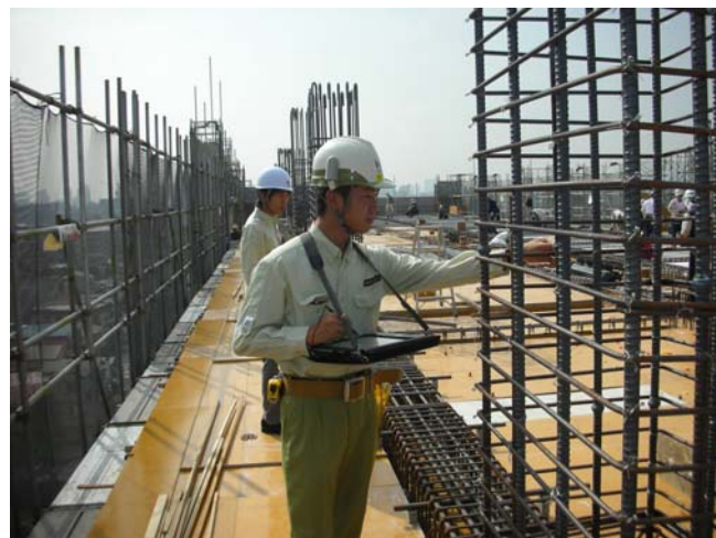
「配検」を使用した配筋検査の様子】
