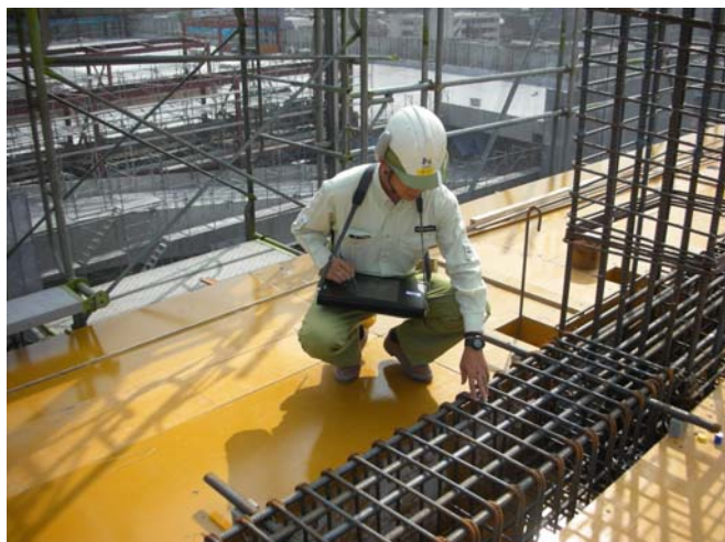
「配検」を使用した配筋検査の様子】
