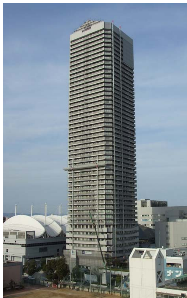
[オークプリオタワー 大規模修繕の様子]
