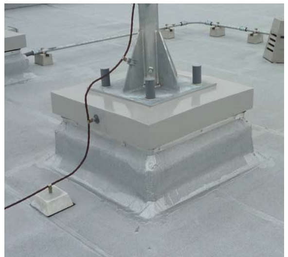
〔「S型枠」を用いた施工例〕
