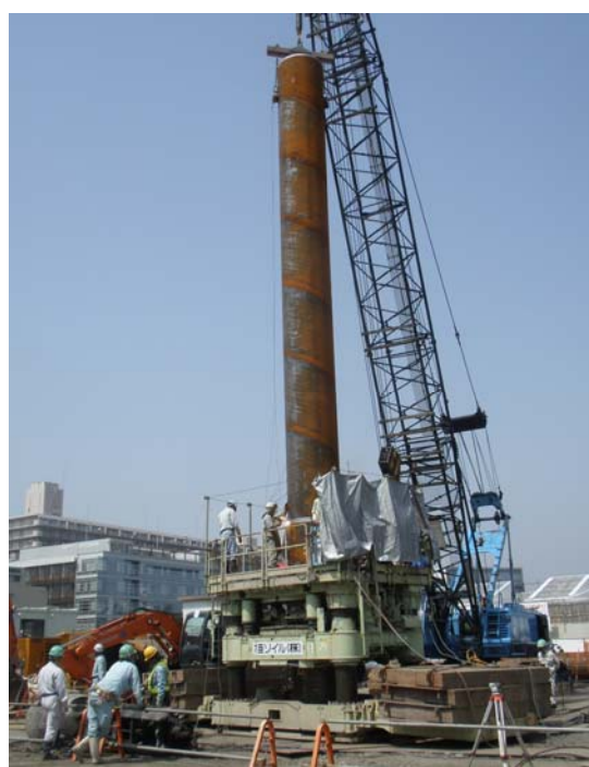
〔左：先端翼付き回転貫入鋼管杭、右：『ジオウイング・パイルⅡ』による施工の様子〕
