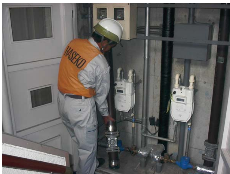
【『HAM-J工法』を施工している様子】
