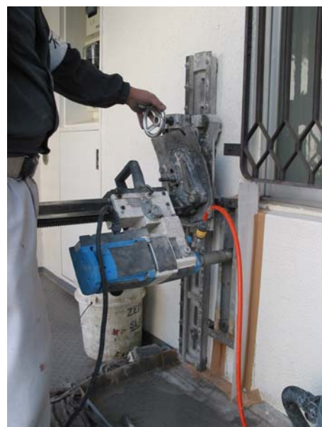
〔部分スリットを施工している様子〕
