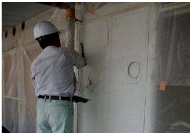
[『サイド・ポ・スト工法』で施工している様子]
