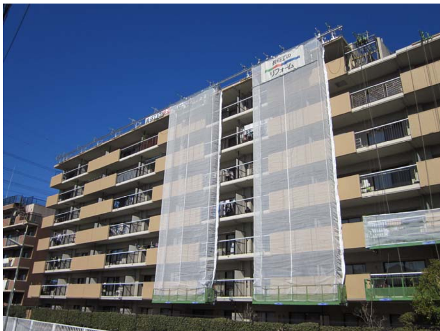
〔『ユニット式ゴンドラシステム』を採用した大規模修繕工事〕
