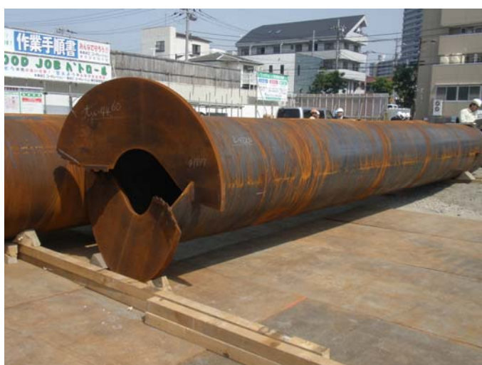
〔左：先端翼付き回転貫入鋼管杭、右：『ジオウイング・パイルⅡ』による施工の様子〕
