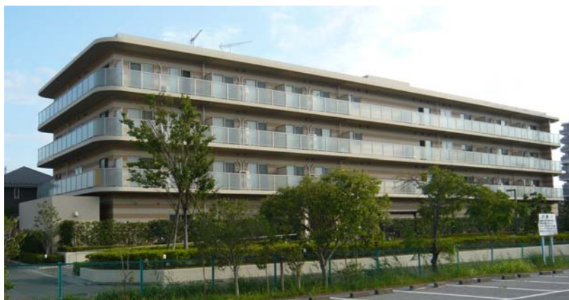
〔『ライブガーデン千葉浜野』建物外観〕
