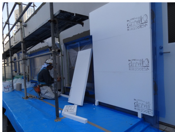
[エステート鶴牧 4・5 住宅(左)、外断熱改修の様子(右) ]
