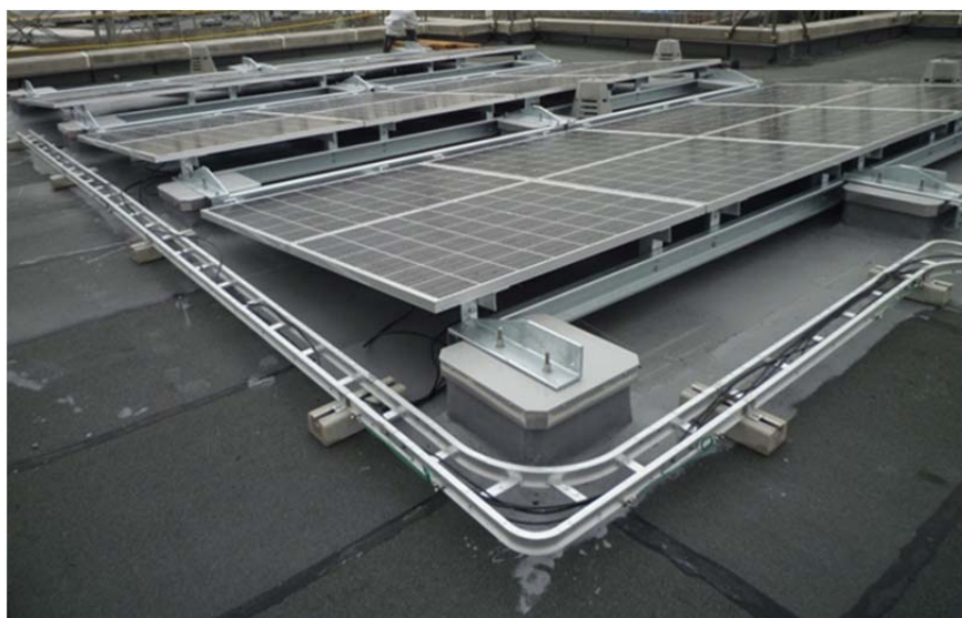
【「ソーラーパネル用低基礎」の設置例】
