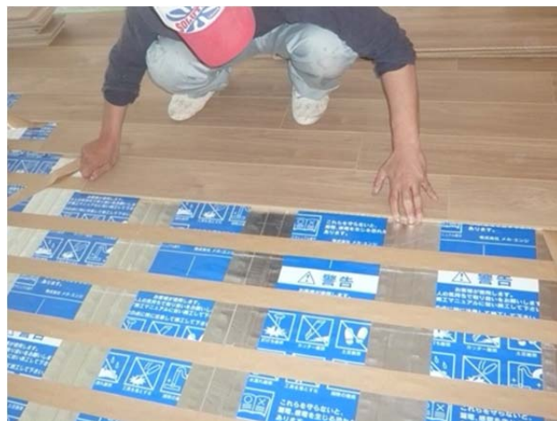
【『暖c e r - R』を施工している様子】
