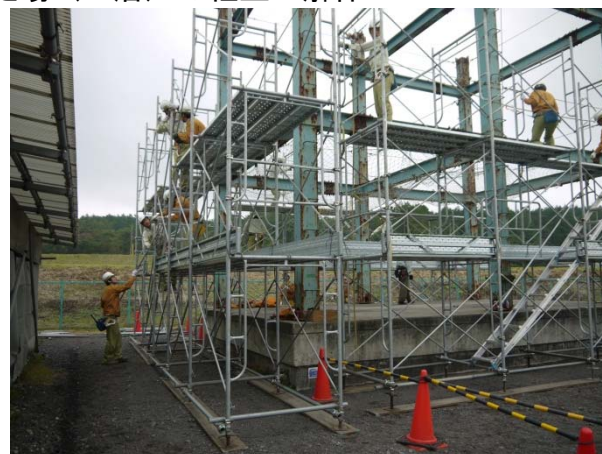
【施工実習の様子（左：ベース型枠の組立、右：枠組み足場の組立）】
