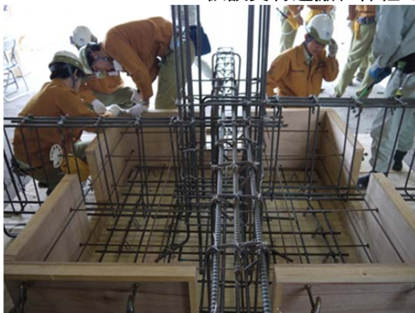
【施工実習の様子（左：ベース型枠の組立、右：枠組み足場の組立）】
