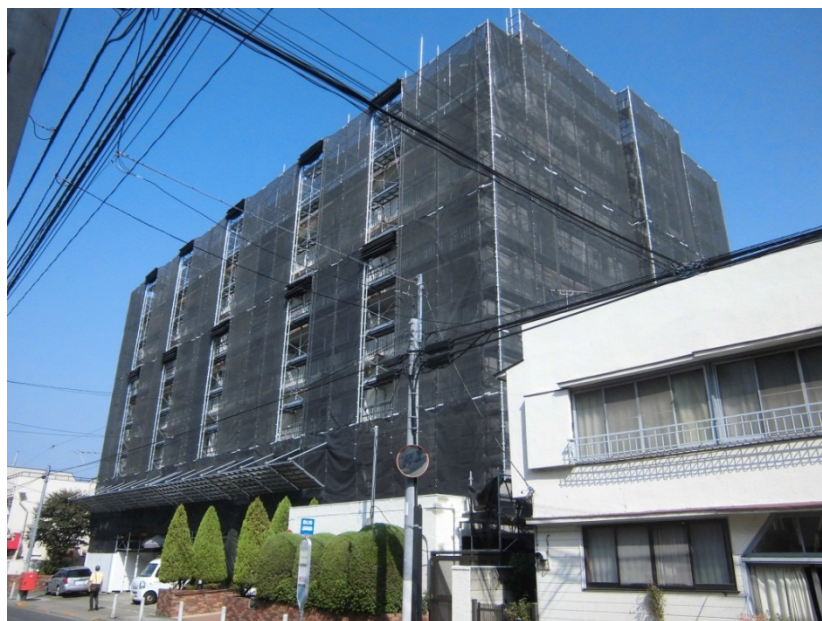
【「楽巻君」を採用した大規模修繕工事の外観】
