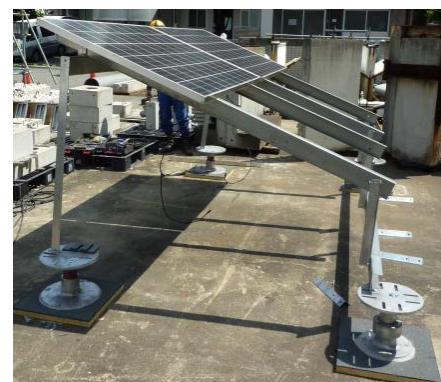
〔「リフォーム用ソーラーパネル架台」(左)、パネルを持ち上げて作業スペースを確保(右)〕
