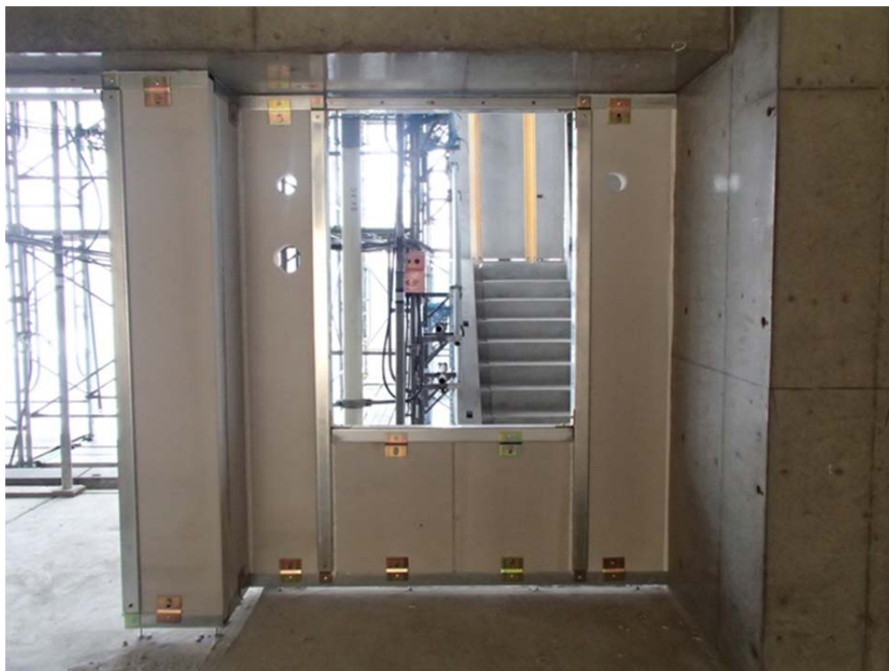
【「ALC金物無溶接工法」で施工した共用廊下側の外壁】
