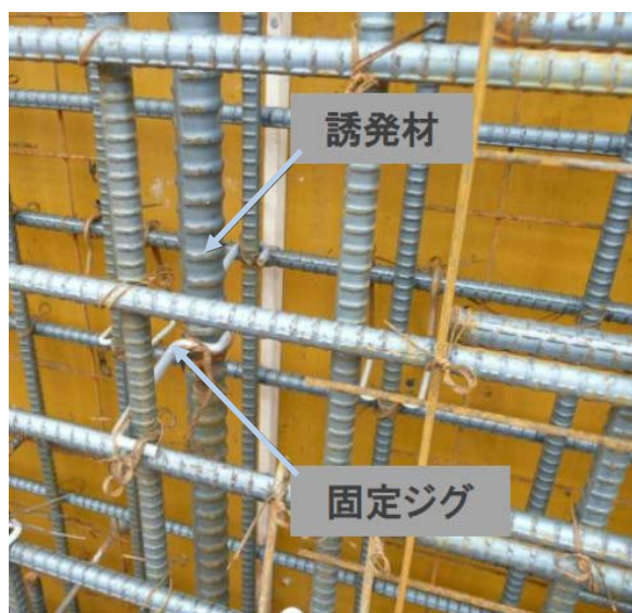
【「CCB-NAC工法」（左：戸境壁の施工例、右：壁断面図）】
