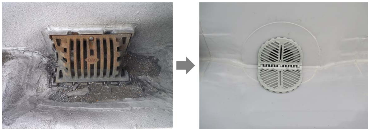
[左：排水部の防水改修前、右：ルーフドレン更生工法（横型）による防水改修後]
