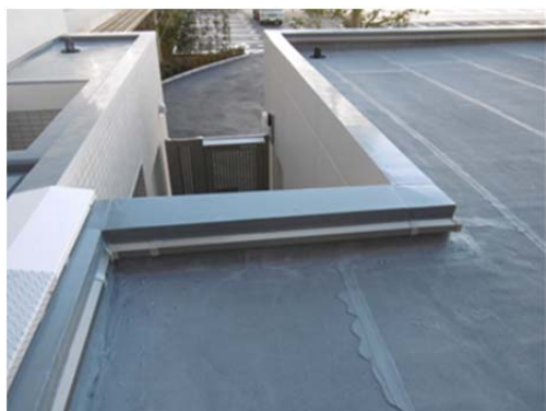
【「セーフティ水切」の施工例】
