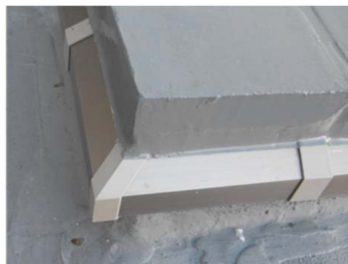
【「セーフティ水切」の施工例】
