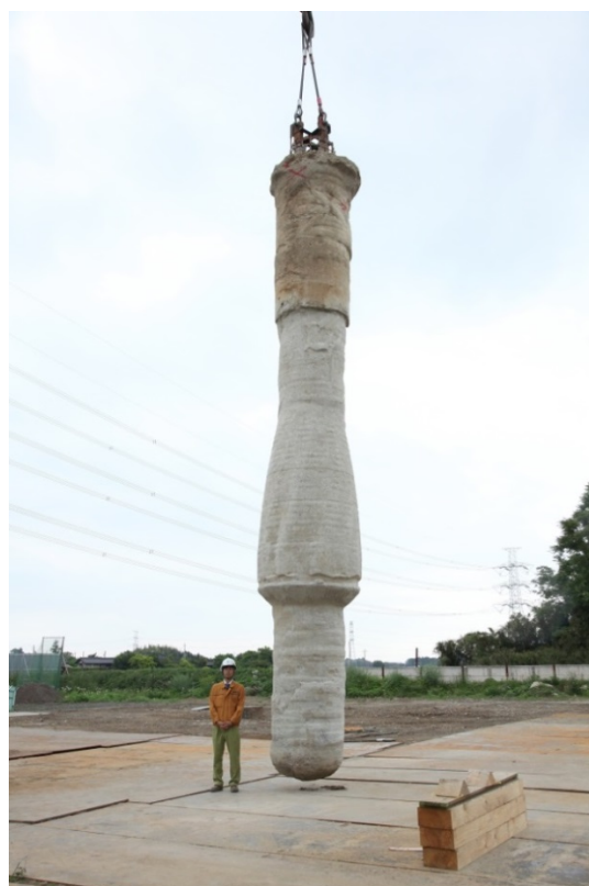
【HND-NB工法により施工した杭】
