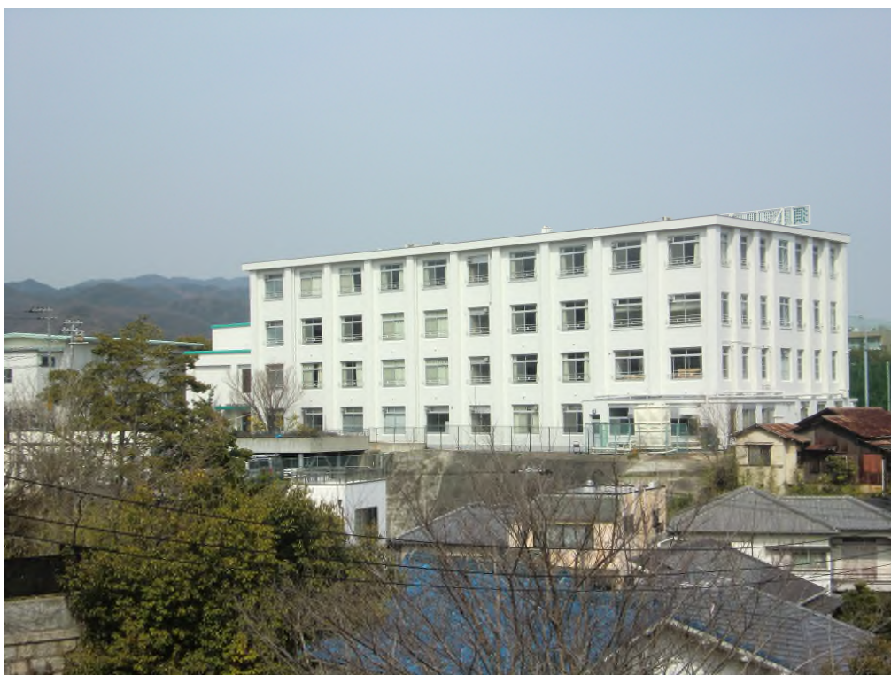
[竣工後の教室・管理棟の外観]
