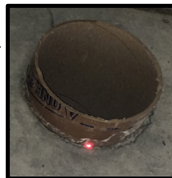
※スリーブの中心位置をレーザにて確認
