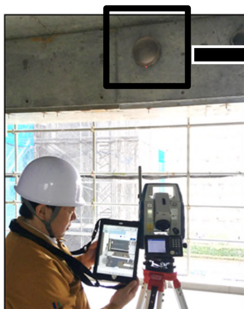
[スリーブの設置位置の確認の様子]
