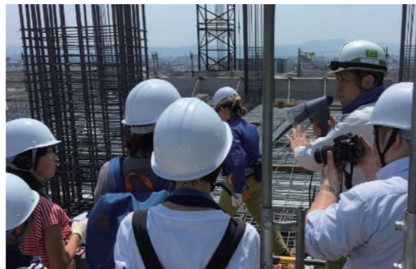
躯体工事施工状況見学の様子
