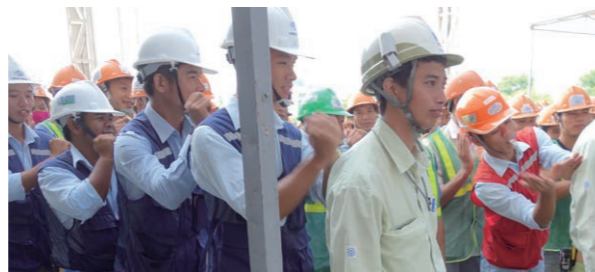
ベトナム建設作業所での安全朝礼の様子
