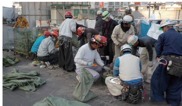
一斉清掃(「(仮称)フージャースケアデザインちはら台新築工事」)
