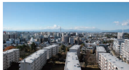
建替え前の藤沢住宅
