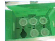
ダウンライト器具に電球をセットし作業所へ納入
