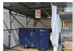
廃石膏ボード分別ヤード(屋根とシートによる防雨対策)
