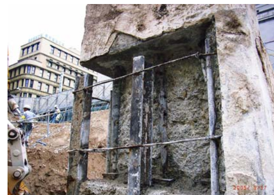
【基礎柱の鉄筋として使用されている「双頭レール」】
