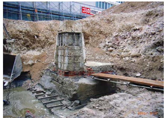
【赤煉瓦（大阪窯業製）の上に建つ基礎柱】 （鉄筋の代わりにレールが使用されている）
