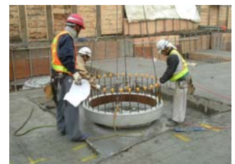
PCリング設置状況
