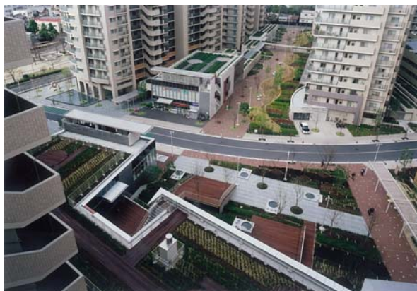
共用棟の屋上緑化
