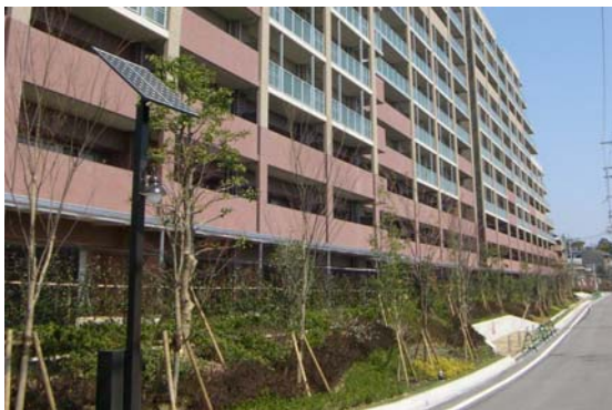
既存樹を活用した沿道の緑化
