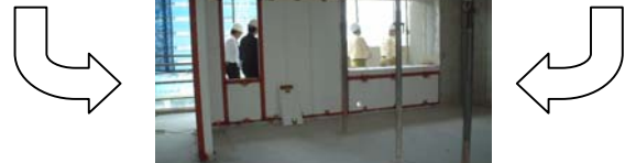
ALC非構造壁の施工状況
