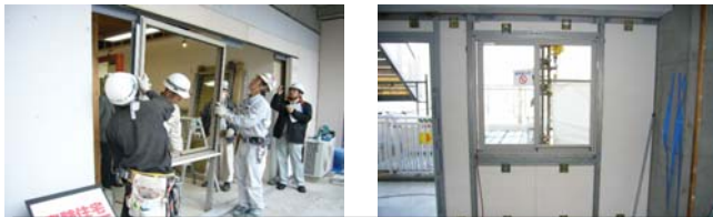
無溶接工法の施工状況
